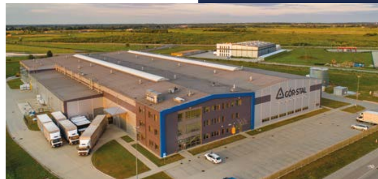
Továrna na izolační desky termPIR® v Bochni
