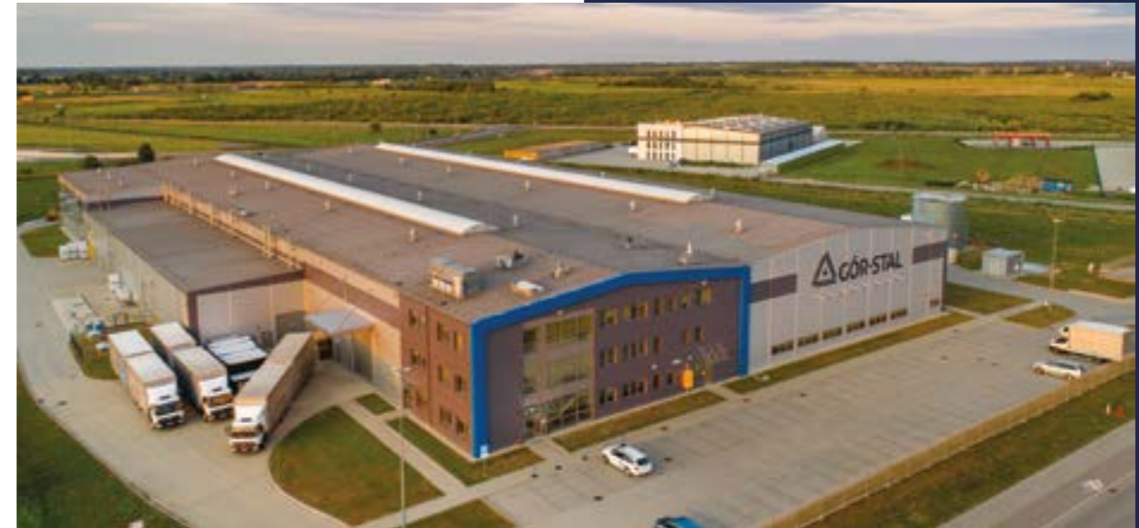
Fabbrica di pannelli isolanti termPIR® con sede a Bochnia
