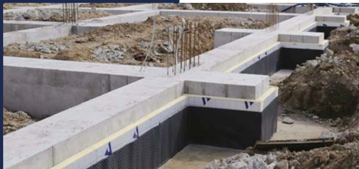
Installazione dei pannelli termPIR® su un pavimenti
