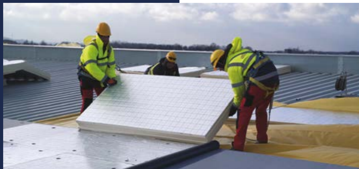
Isolatie van het platte dak met termPIR® panelen
