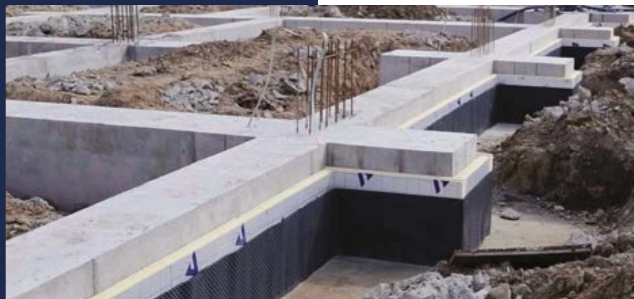
Isolatie van fundaments met termPIR®-platen
