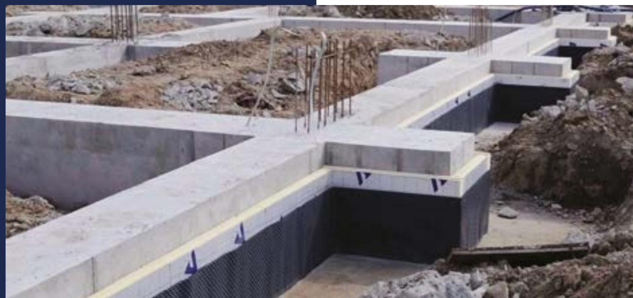
Ocieplenie fundamentów płytami termPIR®
